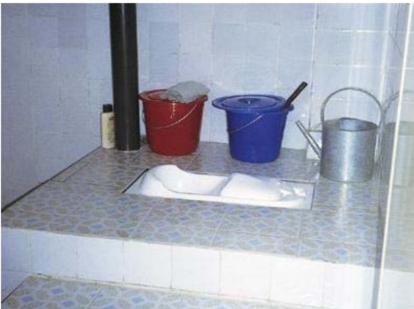
Separations-Hocktoilette in China, Design Lin Jiang (Quelle: U. Winblad, Schweden)
