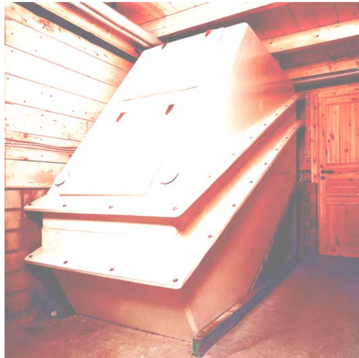
Komposttoilette in Hamburg, nach Berger Biotechnik, Hamburg
