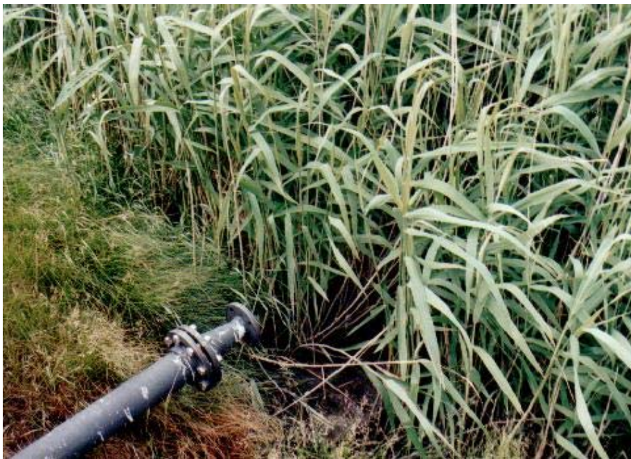
Abbildung 6: Abwasserzulauf in schilfbepflanzte Trockenbeete, Lahstedt*
