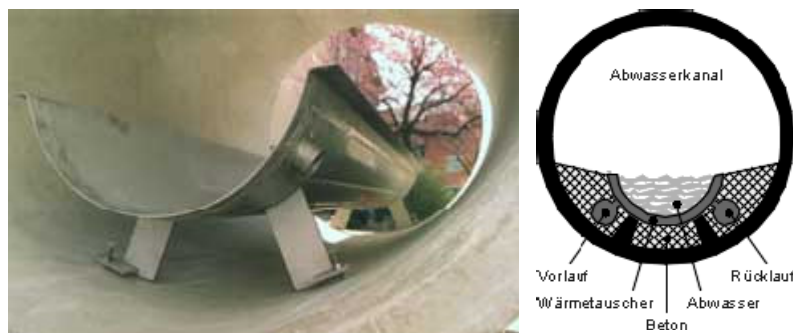
Abbildung 14: Rinnenwärmetauscher für Kanäle mit Kreisprofil*
