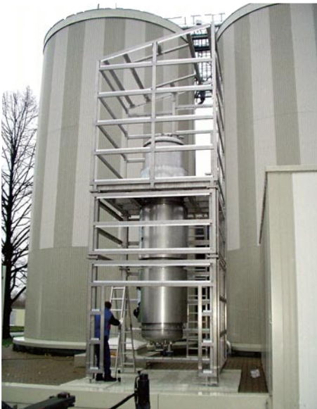
Pilotanlage im Aufbau: Der Bioreaktor zur Vergärung von Klärschlamm wird hinter die Hochlastfaultürme geschaltet.
