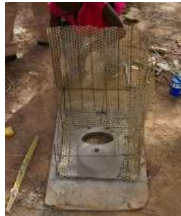
Les dimensions de cette fosse sont Hauteur : 55 cm Largeur : 55 cm Longueur : 60 cm
