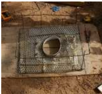
Une cuvette en plastique est utilisée comme moule dans la partie supérieure de la fosse.
