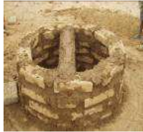
Fosse en construction
