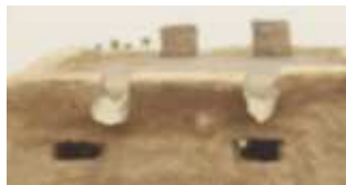
Les cheminées au dessus de la toiture en dalle
