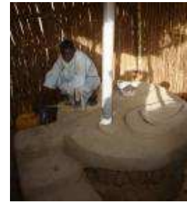
Figure 8. La latrine sèche en matériaux locaux sauf la dalle et le tuyau de ventilation.
