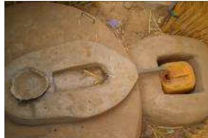
Figure 7. La latrine à compost (Fossa alterna) avec séparation d'urine
